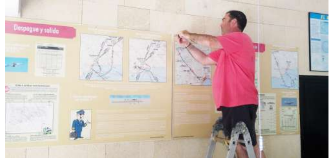
Renovación del pasillo de motores
